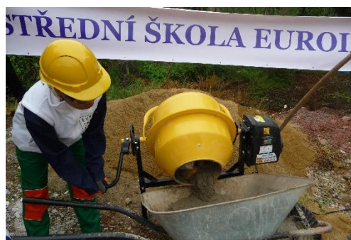
Obrázek 3: Přesun hotové malty do vypláchnutého kolečka
