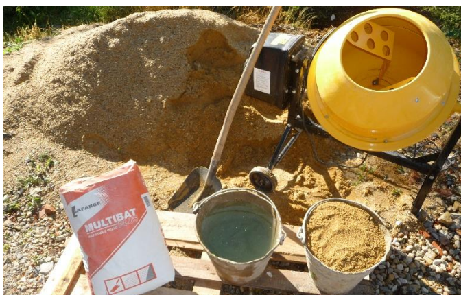
Obrázek 1: Pomůcky a přísady pro výrobu malty
