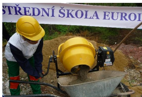
Obrázek 3: Přesun hotové malty do vypláchnutého kolečka
